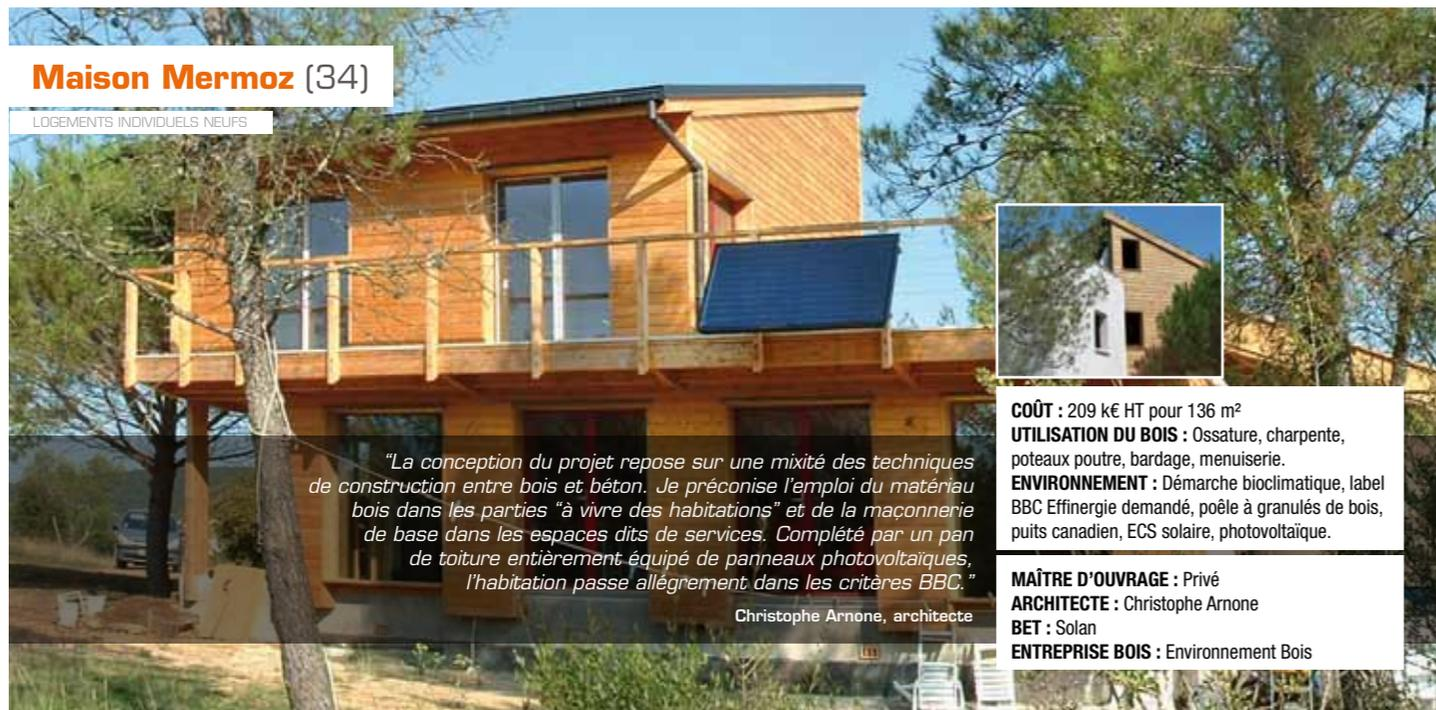
*"La conception du projet repose sur une mixité des techniques de construction entre bois et béton. Je préconise l'emploi du matériau bois dans les parties "à vivre des habitations" et de la maçonnerie de base dans les espaces dits de services. Complété par un pan de toiture entièrement équipé de panneaux photovoltaïques, l'habitation passe allégrement dans les critères BBC."*
