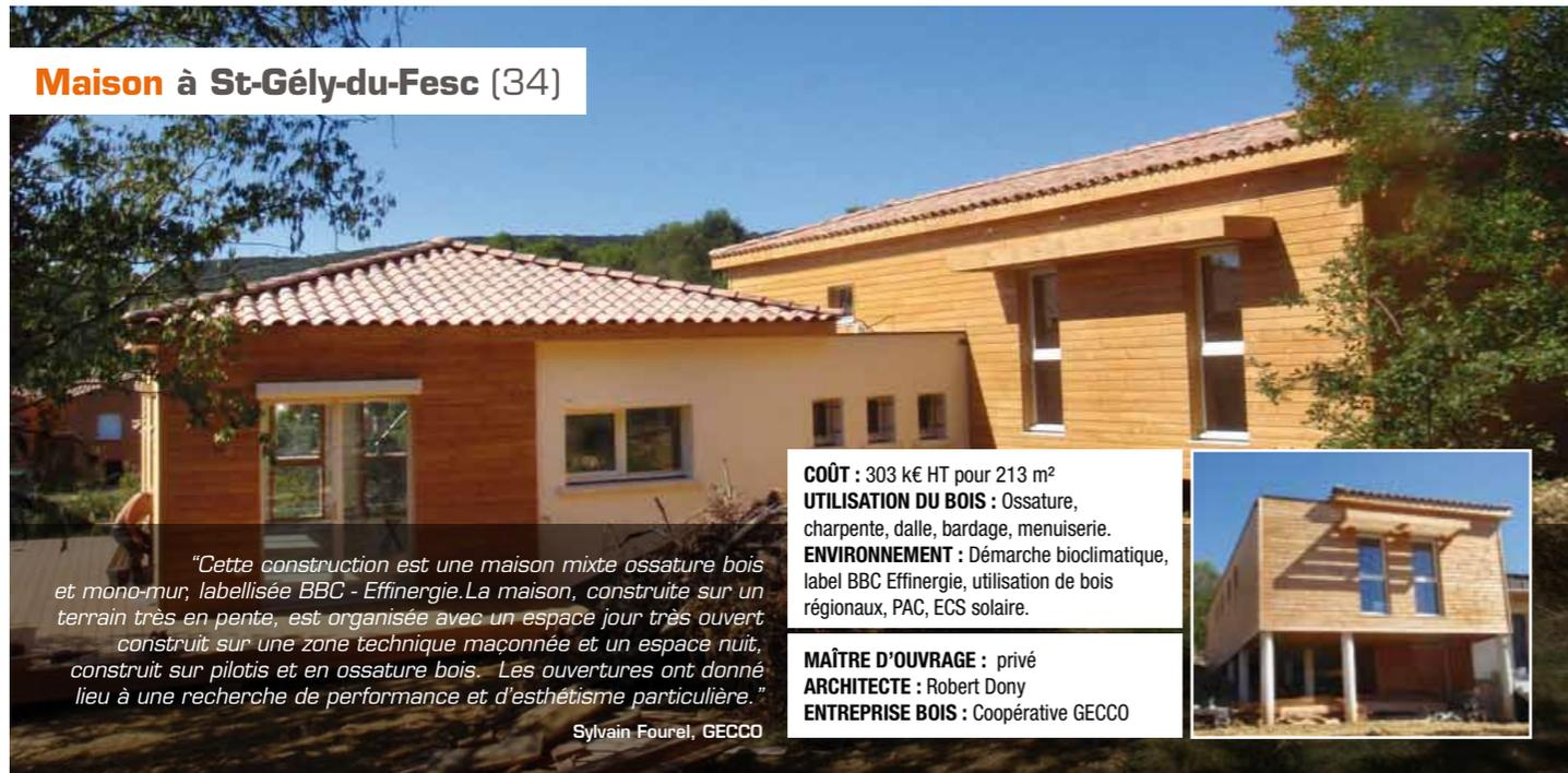
*"Cette construction est une maison mixte ossature bois et mono-mur, labellisée BBC - Effinergie. La maison, construite sur un terrain très en pente, est organisée avec un espace jour très ouvert construit sur une zone technique maçonnée et un espace nuit, construit sur pilotis et en ossature bois. Les ouvertures ont donné lieu à une recherche de performance et d'esthétique particulière."*
