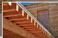
*"Il s'agit d'une cave viticole privée composée d'une cuverie, d'un chai, d'une zone de stockage, d'un accueil pour le public et d'un logement de fonction. Ce bâtiment au volume cubique s'insère dans le paysage grâce au bardage bois. L'ossature bois repose sur une dalle béton et sur des murs monomur pour les zones semi enterrées. Le bâtiment accueille cette année ses premières vendanges."*
